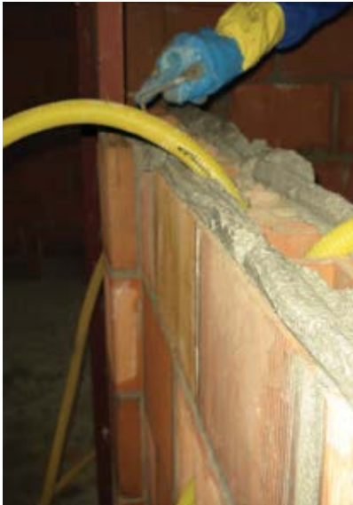
Assentamento de alvenaria de vedação.
