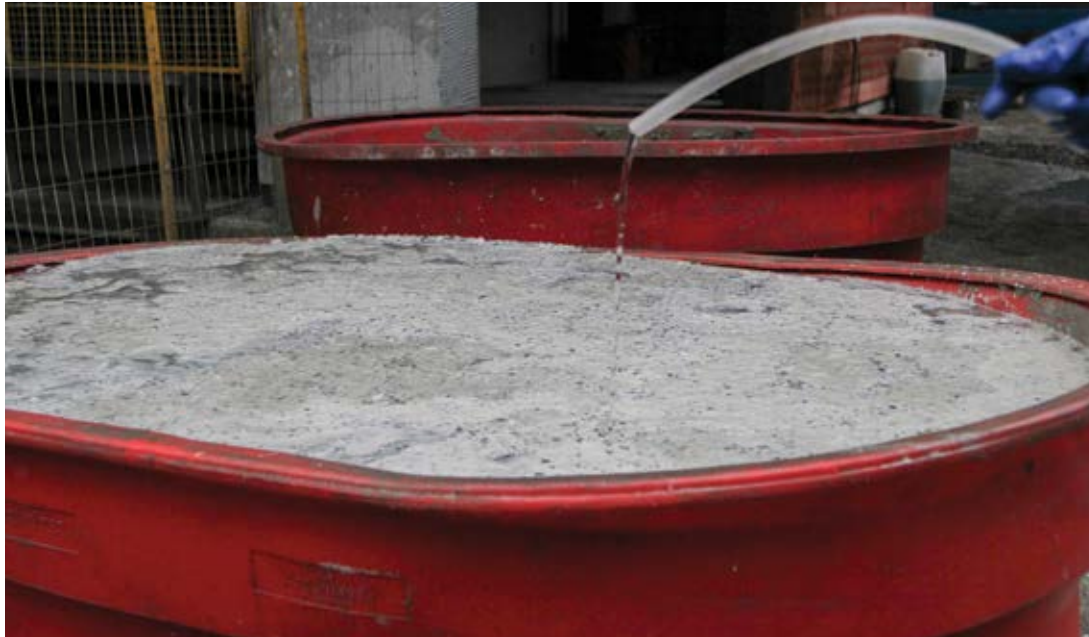
Argamassa com película de água.
