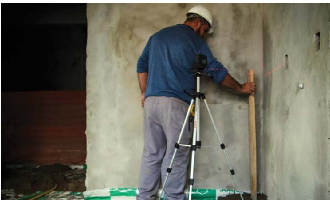
Execução de contrapiso sobre manta acústica.
