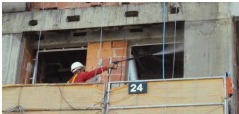
Lavagem da fachada.
