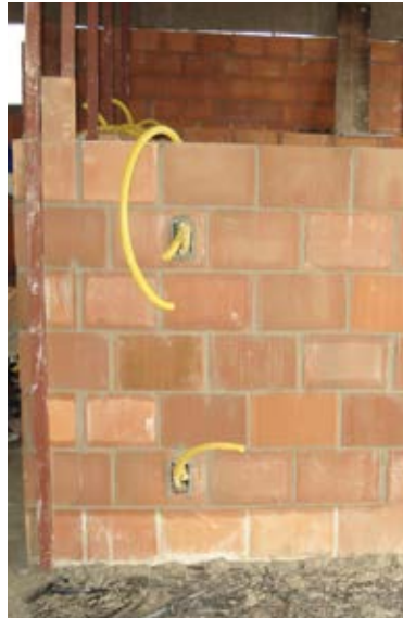
Preparo da alvenaria de vedação.
