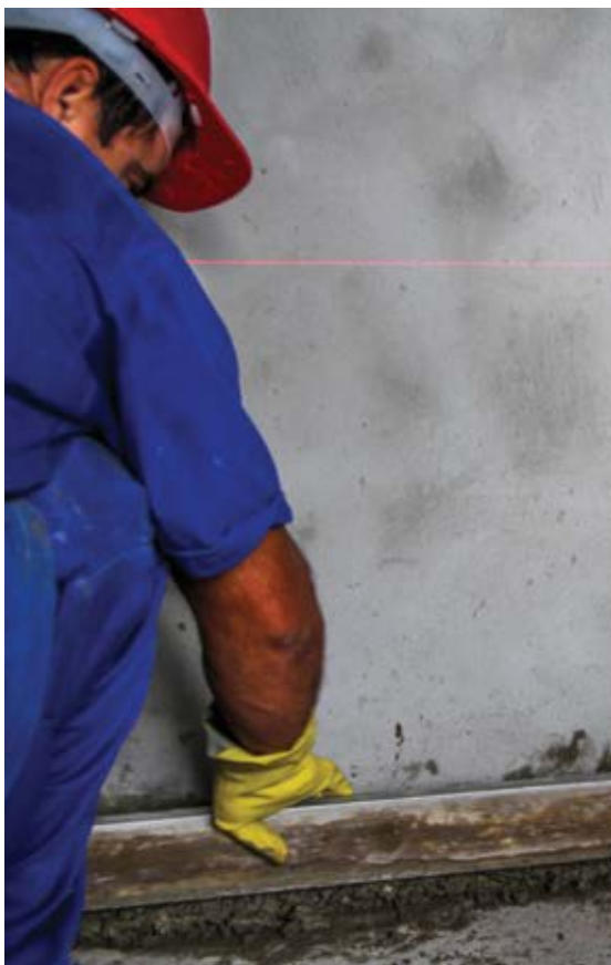
Execução de contrapiso - nivelamento.
